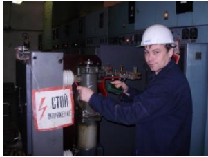
5. Проверка изоляции
